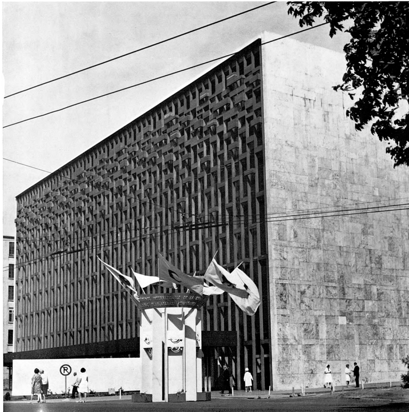
Sede de la Conferencia Palacio de la Cultura - Ópera (1969, arquitecto Dr. Ing. Hayati Tabanlıoğlu)
