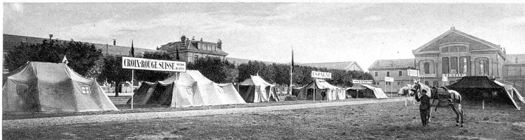
ENTRÉE DE L'EXPOSITION, VUE D'ENSEMBLE
