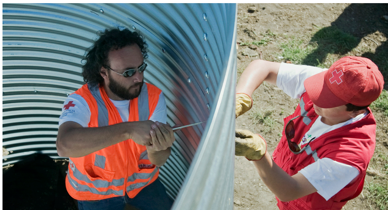
Voluntarios de la Cruz Roja Chilena y de la Federación instalan un tanque tipo Oxfam de 11 mil litros en uno de los cuatro campamentos de los damnificados de Tubul. Cruz Roja Chilena, 2021.
