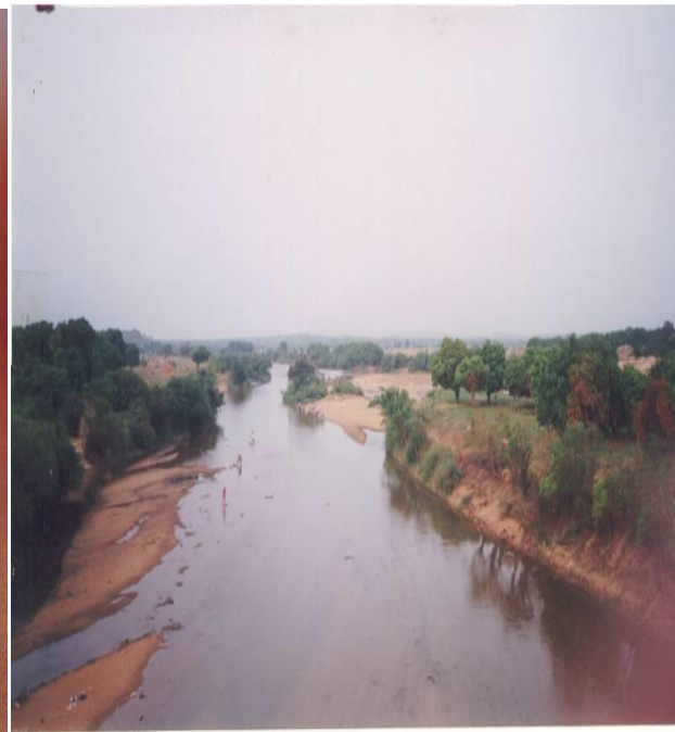
Photo 7: dégradation des berges du Niger
