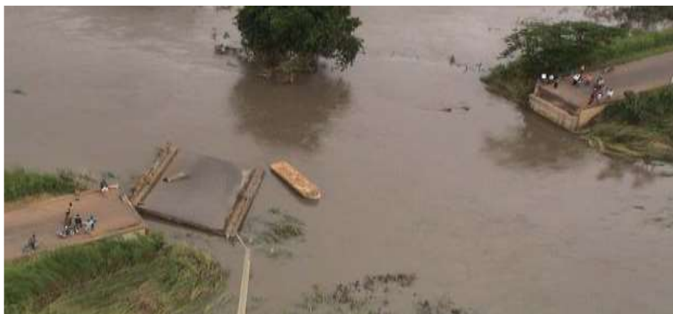
Photo 1. Rupture du pont sur la route nationale N°1 à AMAKPAPÉ
