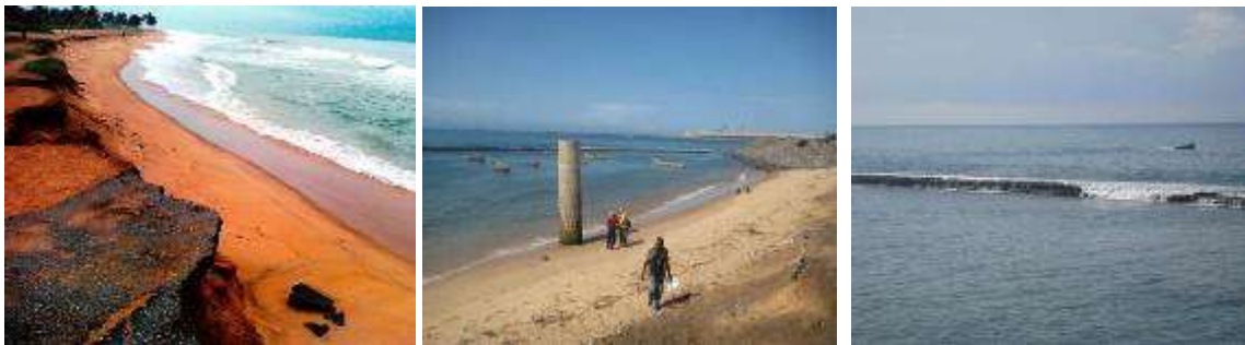
Photo 5. Route nationale N°2 détruite ; Puits d'une maison emportée ; Exhumation du Beach Rock 6 par l'érosion côtière
