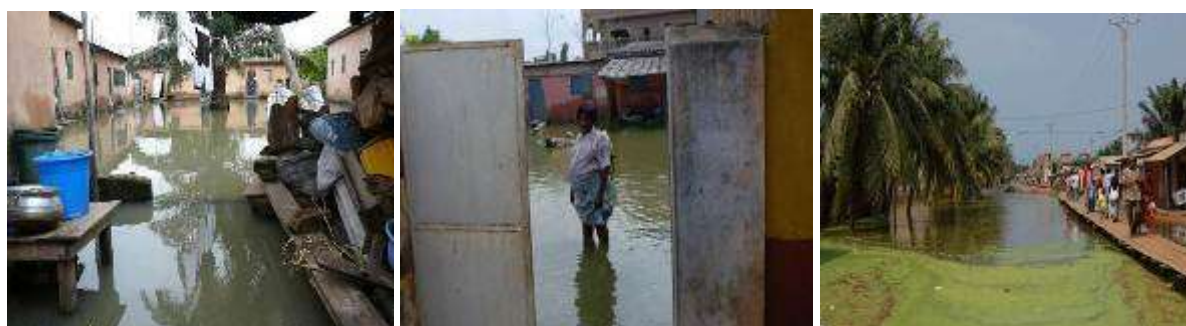
Photo 3. Maisons inondées à Lomé et eaux stagnantes à Baguida
